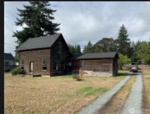
2019 Bowker Exterior Front.jpg
