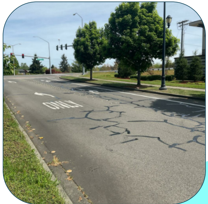
Fig. 9 Balustrade Blvd SE
