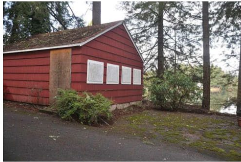
070 SE corner of garage.jpg
