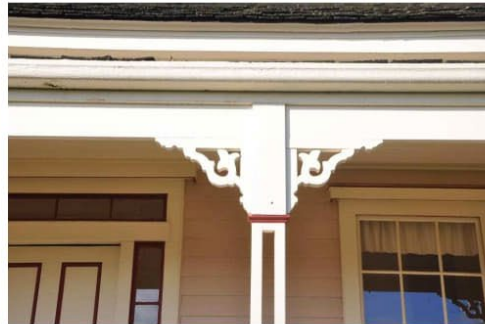
035 Porch trim CloseUp.jpg
