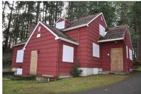
030 NE corner of house.jpg
