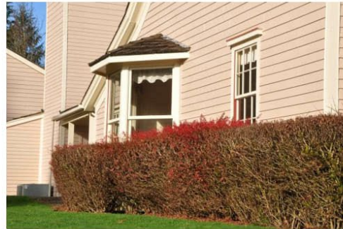
045 SW Bay Window facing NE.jpg
