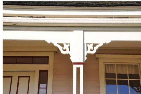
035 Porch trim CloseUp.jpg
