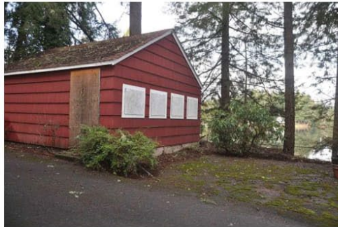
070 SE corner of garage.jpg
